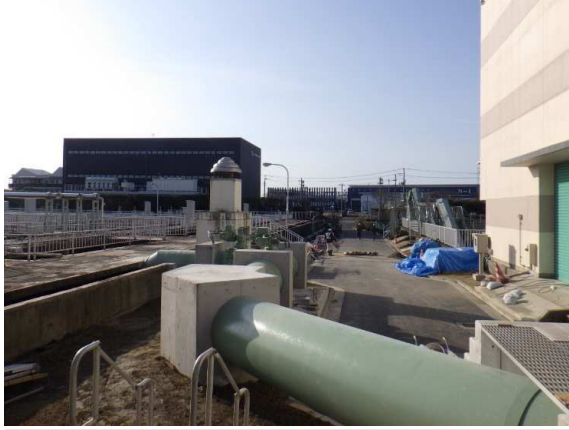
バイパス管布設完了
