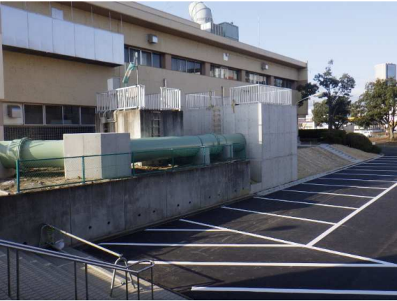
バイパス管布設完了
