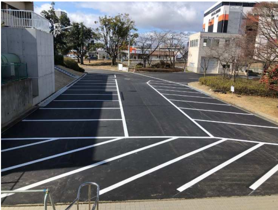
敷地内舗装・区画線完了
