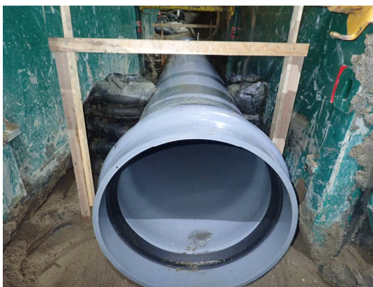
新設合流管布設完了
