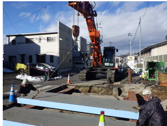
覆工板設置状況
