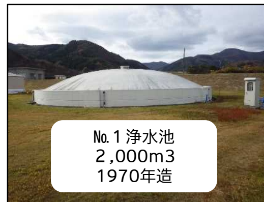
【現況No.1浄水池】
