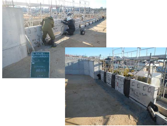
コンクリート壁面材(6段目)設置状況(東側)
