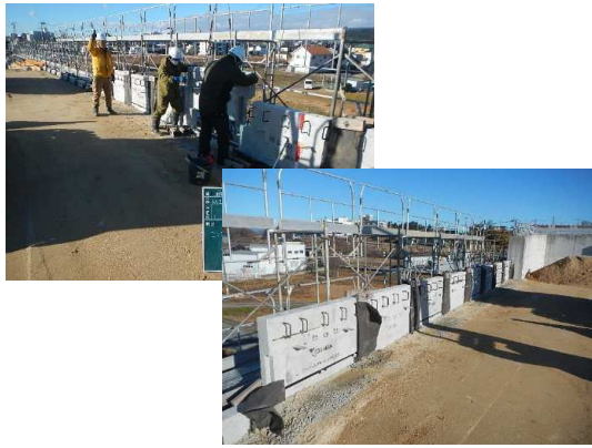
コンクリート壁面材(6段目)設置状況(西側)
