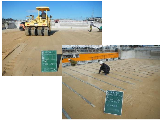
路体盛土、補強土壁工(ストリップ 設置)状況
