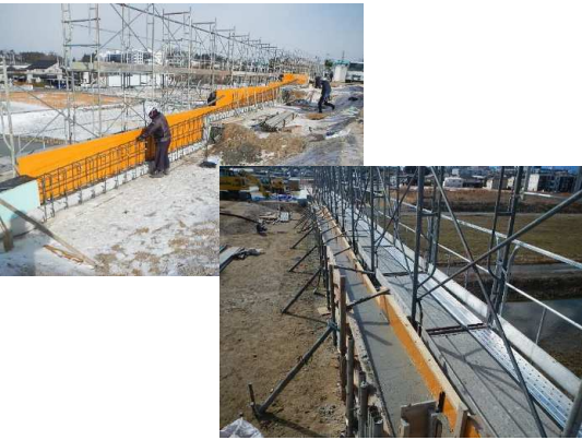
笠石コンクリート施工状況
