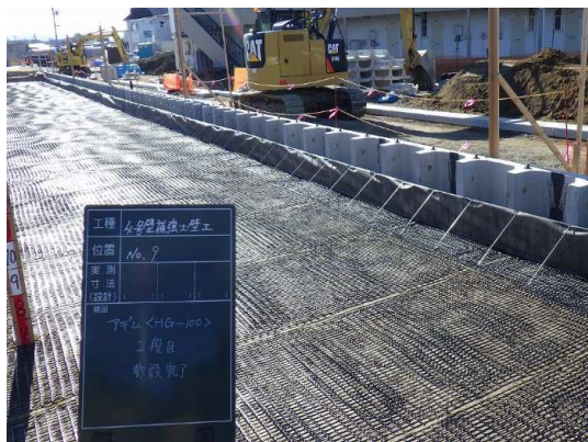
補強土壁工(補強材設置)施工状況
