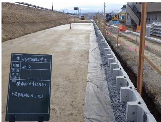
補強土壁工(壁面排水層設置)施工状況
