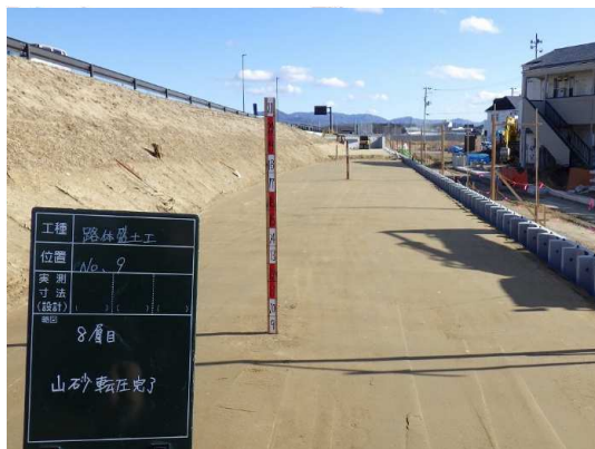
補強土壁工(路体盛土)施工状況
