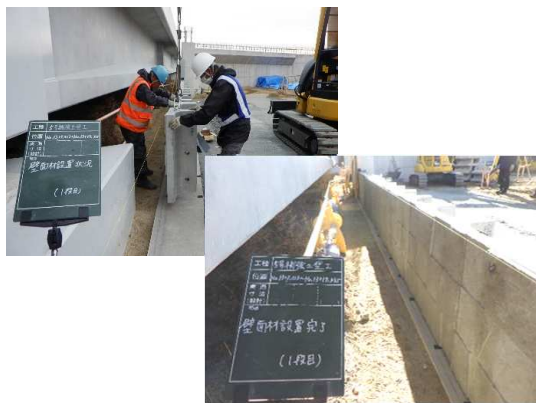
補強土壁工(コンクリート壁面材設置)施工状況
