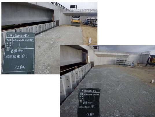
補強土壁工(基盤排水工)施工状況
