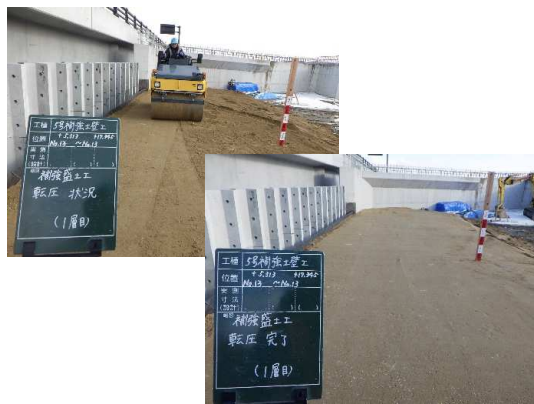
補強土壁工(路体盛土)施工状況
