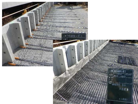
補強土壁工(補強材設置)施工状況
