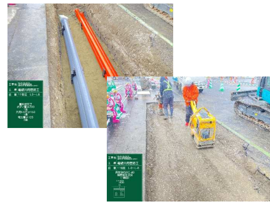
電線共同溝(管路部)施工状況
