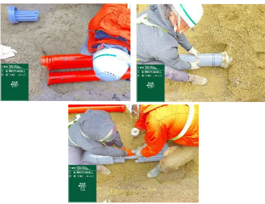
電線共同溝(管路部)施工状況
