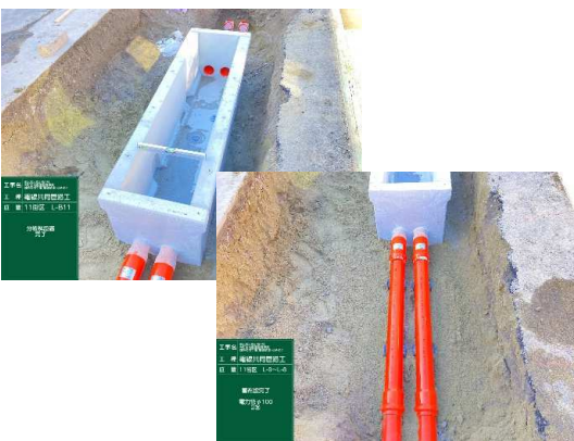
電線共同溝(管路部)施工状況
