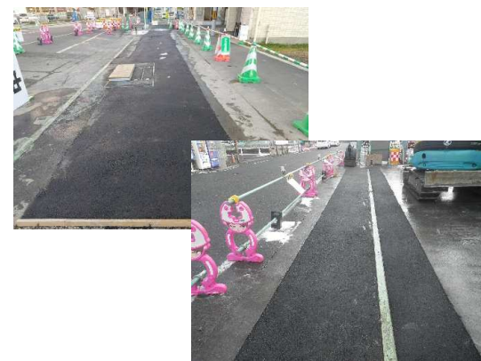
舗装仮復旧施工状況
