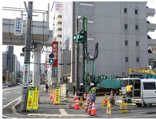
小口径回転杭工施工状況(南側を望む)
