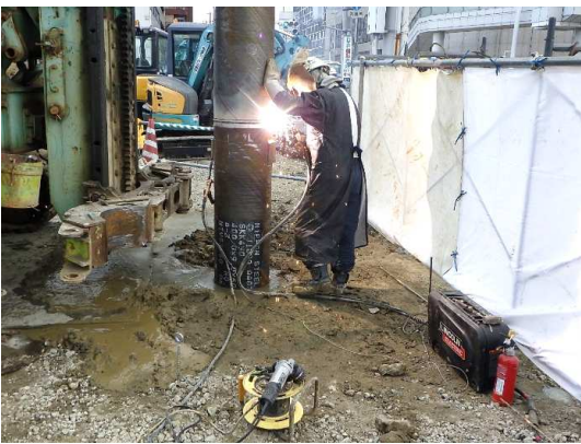
小口径回転杭工施工状況
