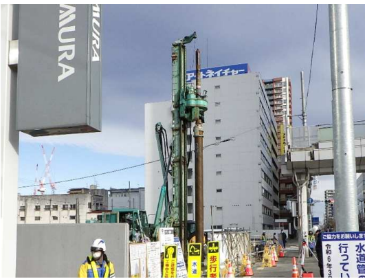
小口径回転杭工施工状況(北側を望む)
