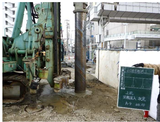
小口径回転杭工施工状況
