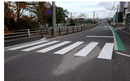
令和元年度施工
