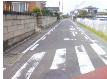
令和5年度施工
