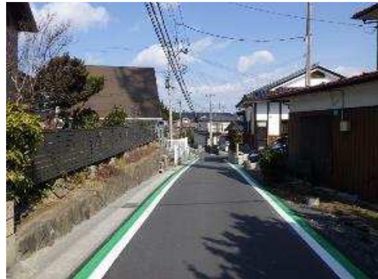
令和元年度施工
