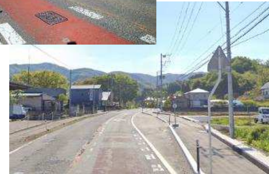
令和元年度施工
