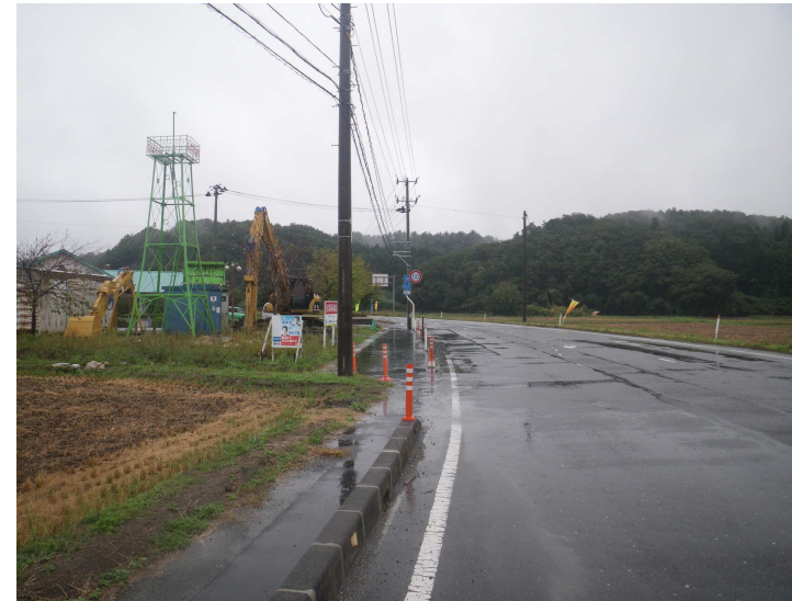
平成25年度施工
