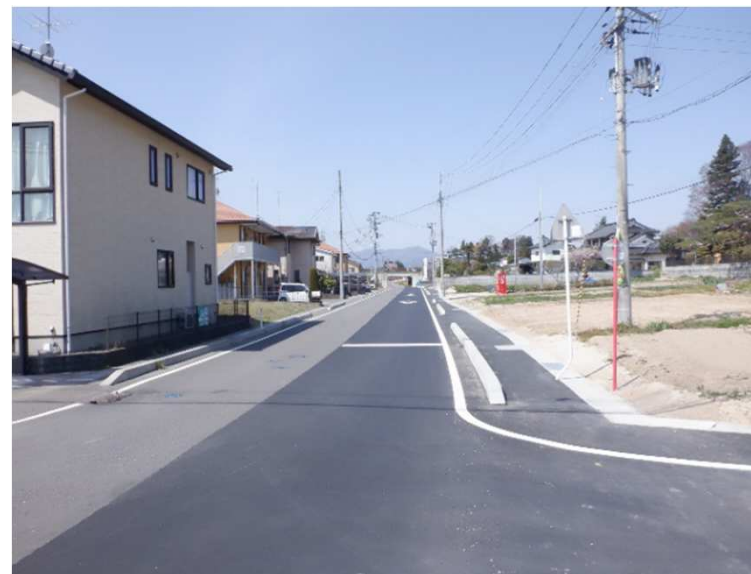
令和4年度施工
