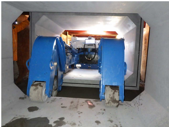
ボックスカルバート布設状況
