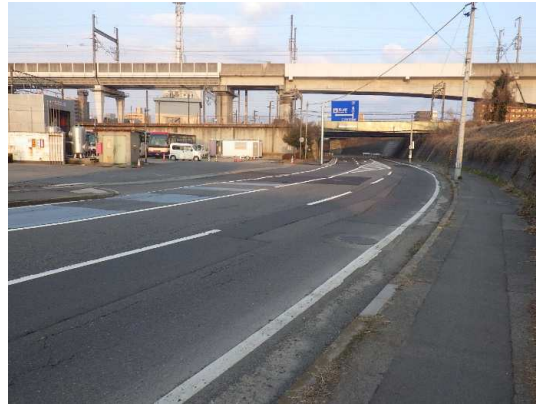
舗装仮復旧完了
