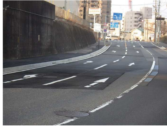
舗装仮復旧完了
