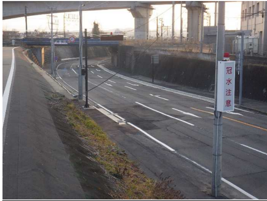
舗装仮復旧完了
