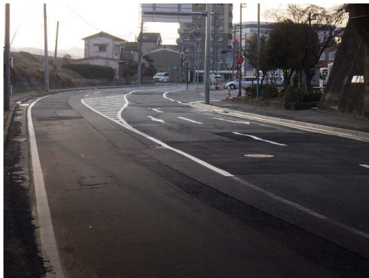
舗装仮復旧完了
