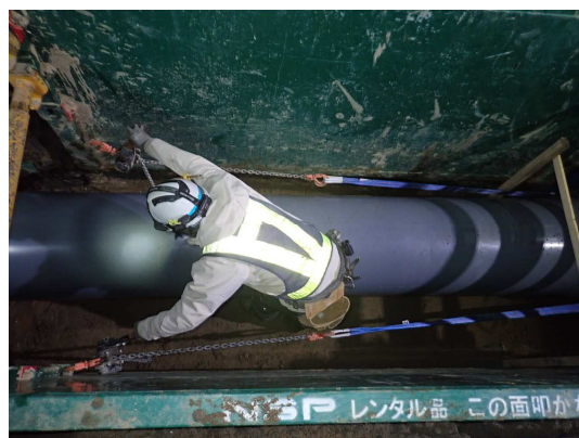
新設合流管布設状況
