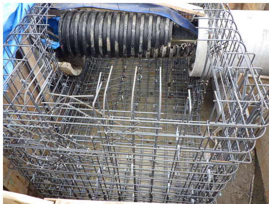
鉄筋組立状況
