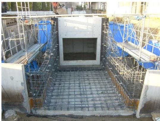
翼壁部 底版・側壁鉄筋組立完了
