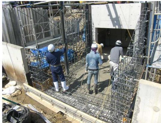
翼壁部 底版コンクリート打設状況
