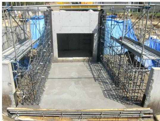
翼壁部 底版コンクリート打設完了
