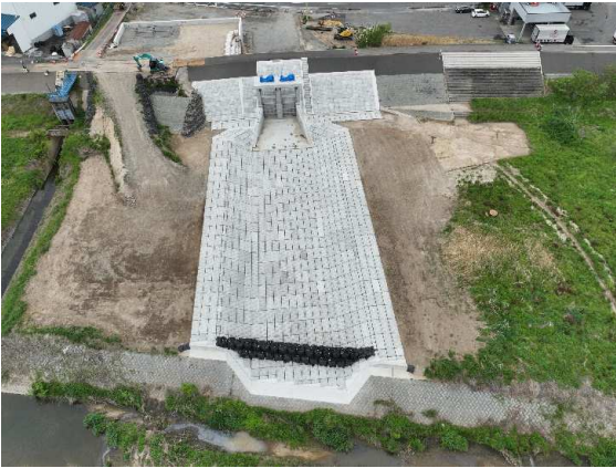
取付水路完了
