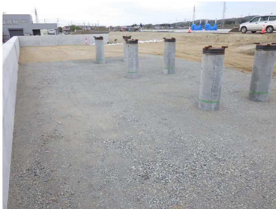
発電機置場盛土状況
