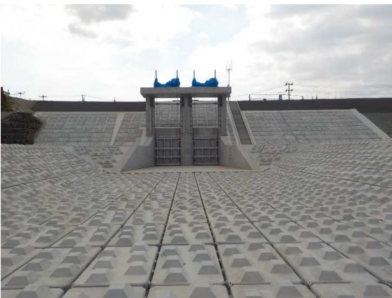
取付水路完了
