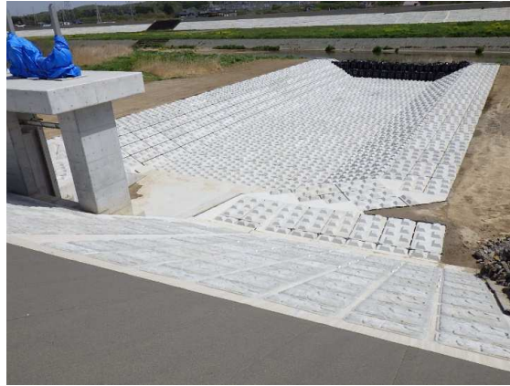
取付水路完了
