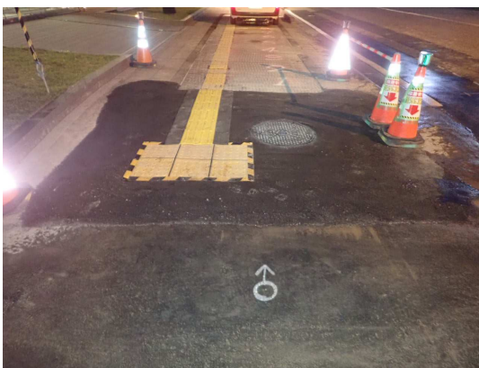
2号人孔舗装仮復旧完了
