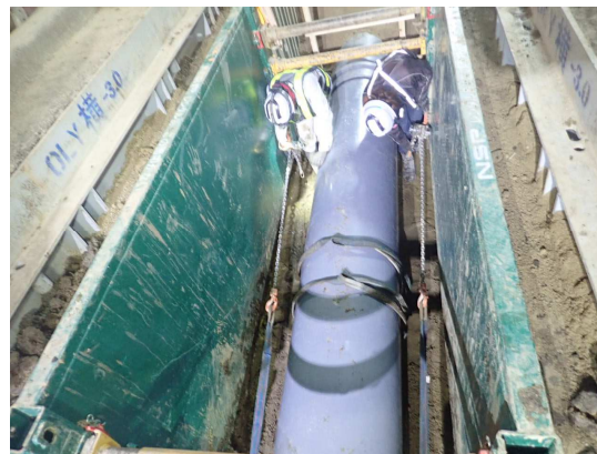
新設下水管布設状況
