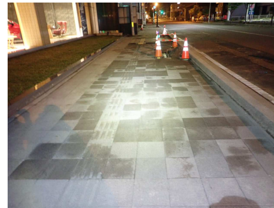
平板ブロック設置完了
