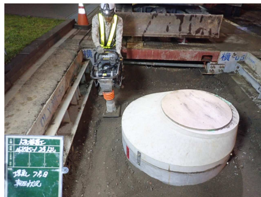
2号人孔埋戻し転圧状況
