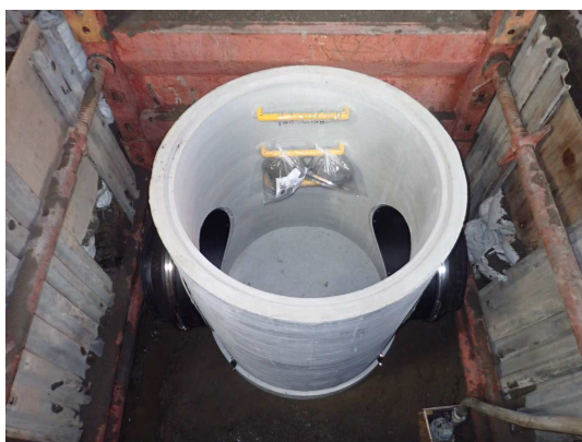
2号人孔底版・管取付壁設置完了
