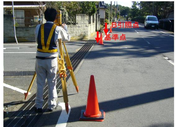
A 引照点でのTSによる視準(A引照点～基準点～B引照点)
