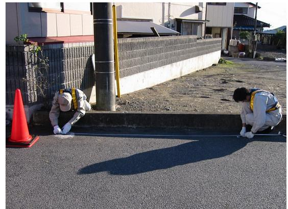
水平距離の測定(B・D引照点～基準点)
