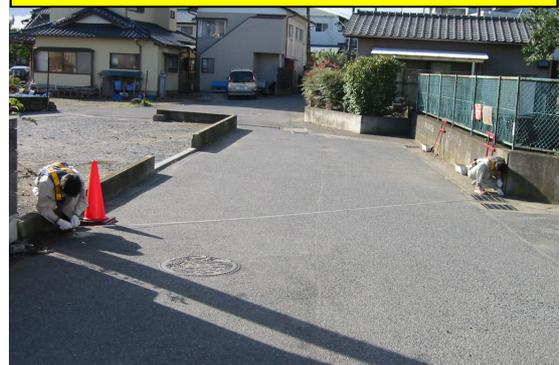
水平距離の測定(基準点～引照点)
