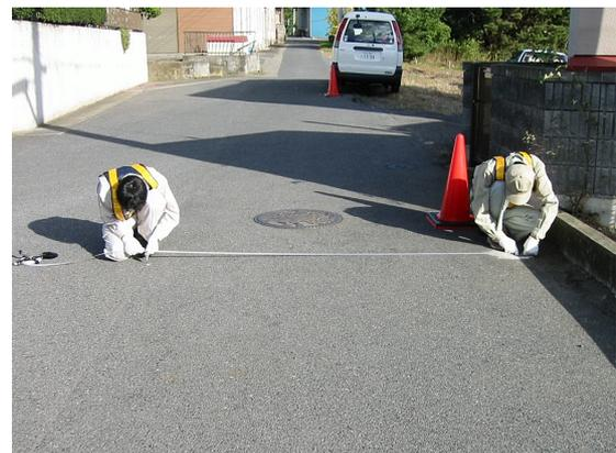
水平距離の測定(D引照点～基準点)
