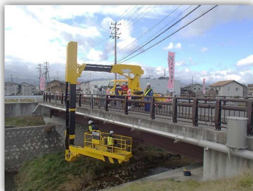
▲橋梁点検車での点検
