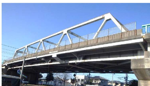
▲重点管理橋梁 JR 線路を跨ぐ橋 ・大黒橋（橋長 153m、幅員 18m）
