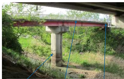
橋脚 主桁 橋台
