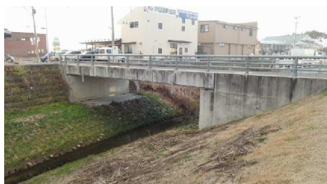
▲簡易予防保全橋梁 ・静岡橋（橋長 14.2m、幅員 6.0m）
