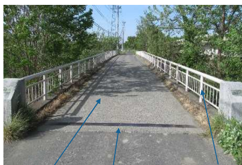
舗装 伸縮装置 高欄
