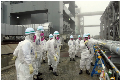
凍土遮水壁工事現場で説明を受ける委員ら
