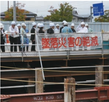
現地調査(古川ポンプ場増設工事)
