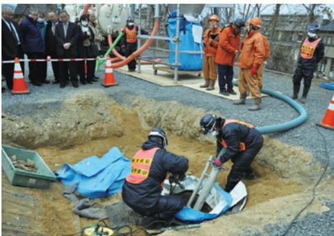
仮埋設保管土吸引システム実証実験
