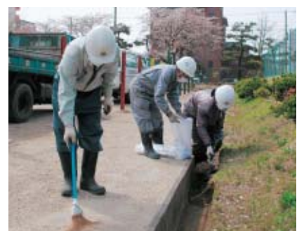
側溝の除染作業(薫小学校)
