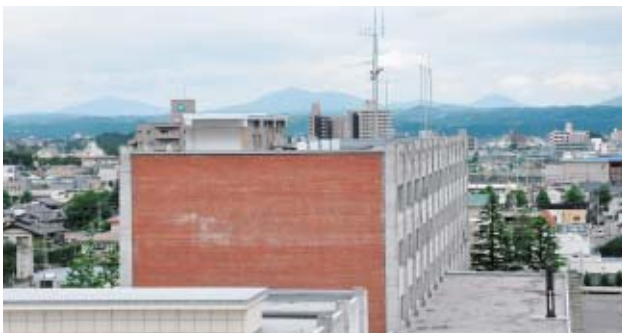
展望台が取り壊された本庁舎屋上
