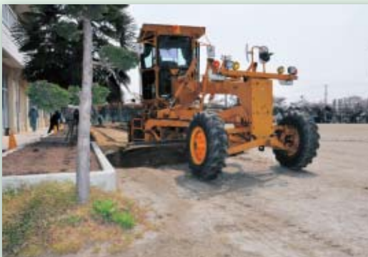
グレーダーによる校庭表土除去作業(薫小学校)
