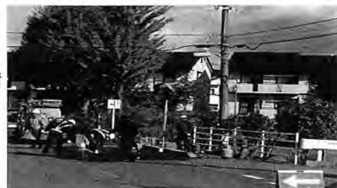
安積町荒井字鎗ヶ池付近の市道の補修
