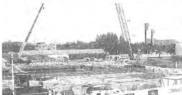
現在建設中のプール
