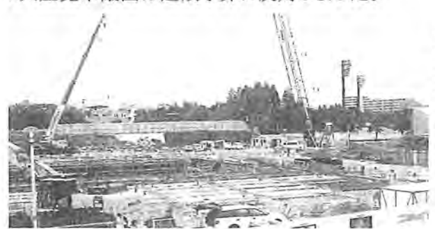
現在建設中のプール
