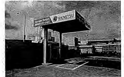
成田水素ステーション
