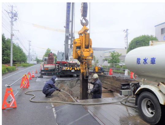
親杭（H鋼）引抜き状況
