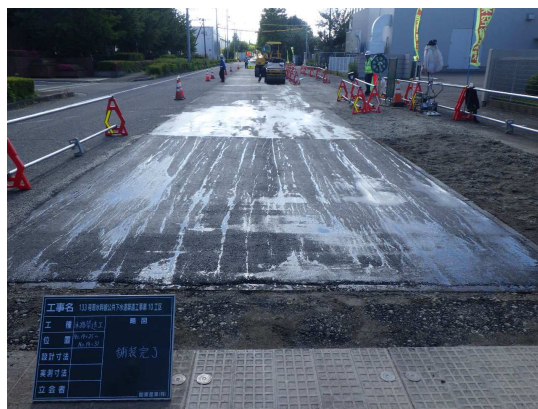
舗装仮復旧完了
