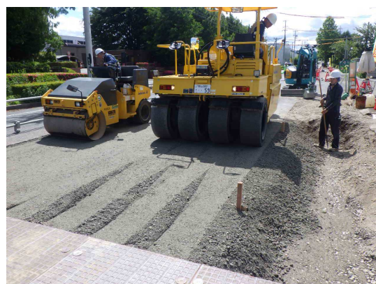
路盤転圧状況
