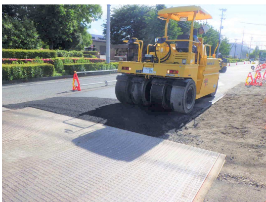
舗装仮復旧施工状況
