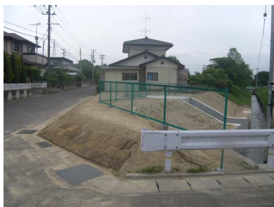
工事完了（現場全景）
