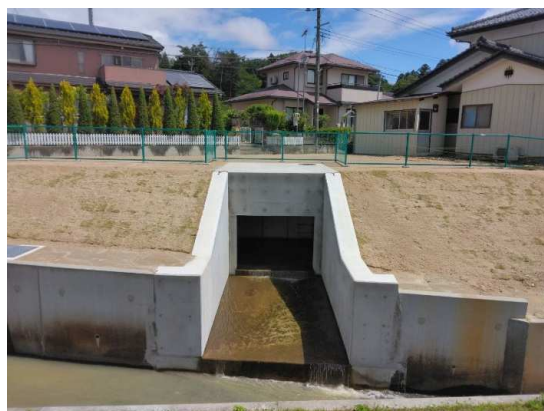
翼壁埋戻し完了
