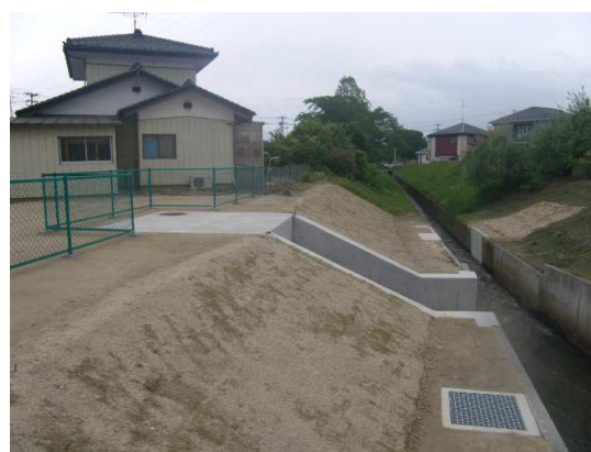
特殊人孔埋戻し・造成工完了
