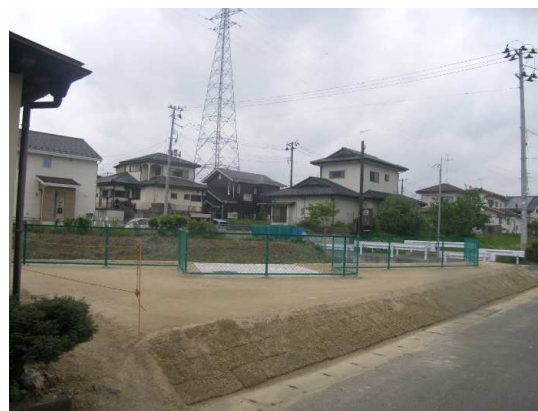
工事完了（現場全景）
