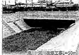
南川(河川)改修工事L=50m
