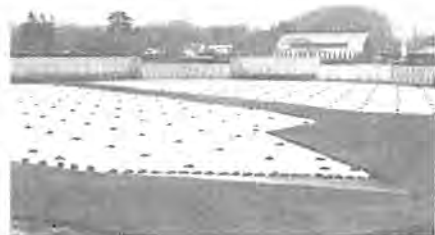
完成した東山霊園積込場
