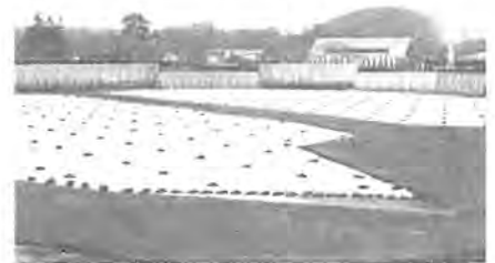
完成した東山霊園積込場
