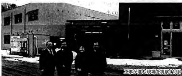
工事が進む現場を視察(1月)
