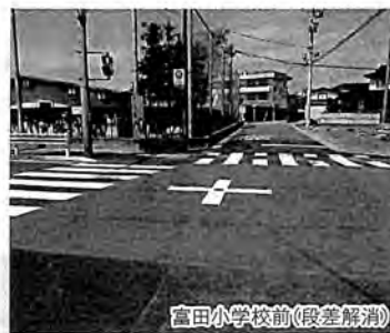
富田小学校前(段差解消)
