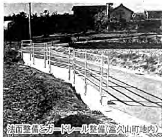
法面整備とガードレール整備(富久山町地内)
