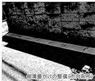
側溝蓋がけの整備(市内各所)
