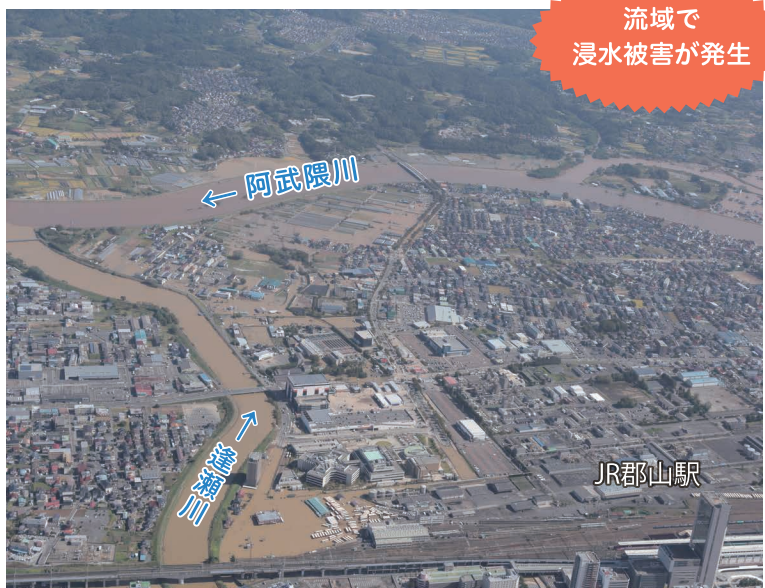
■令和元年東日本台風による浸水被害・阿武隈川合流点付近
