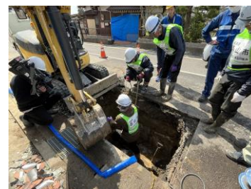
▲応急復旧の様子
