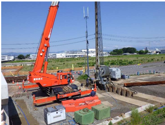
鋼矢板施工状況
