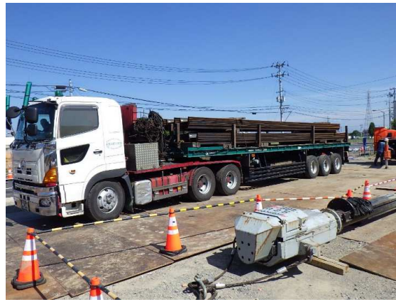
鋼矢板搬入状況
