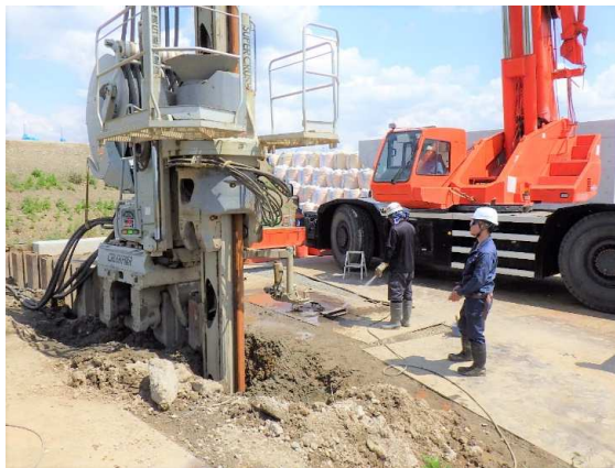
鋼矢板施工状況
