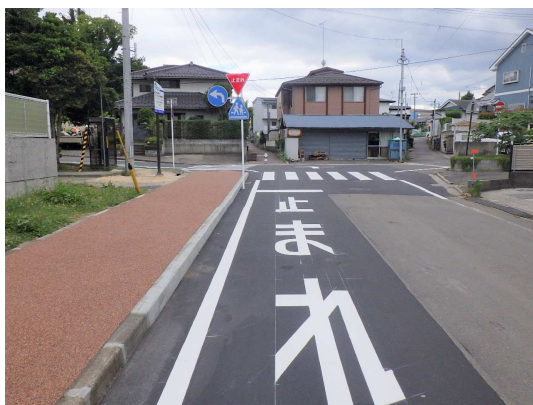
舗装本復旧完了
