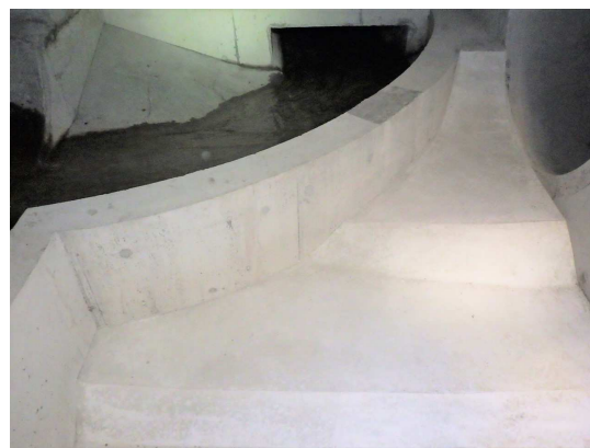
特殊人孔内部状況
