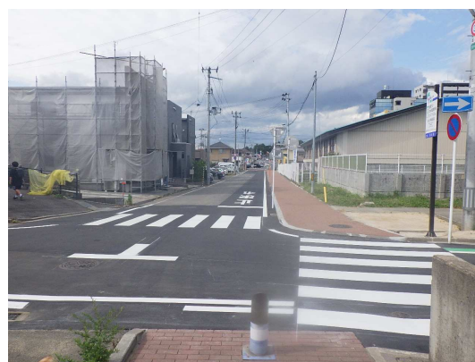
舗装本復旧完了
