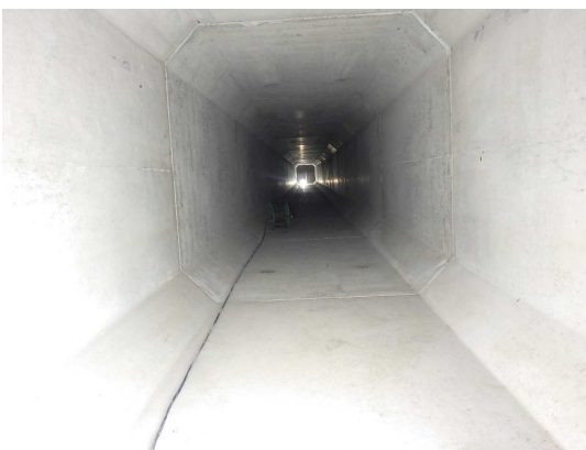
ボックスカルバート内部状況
