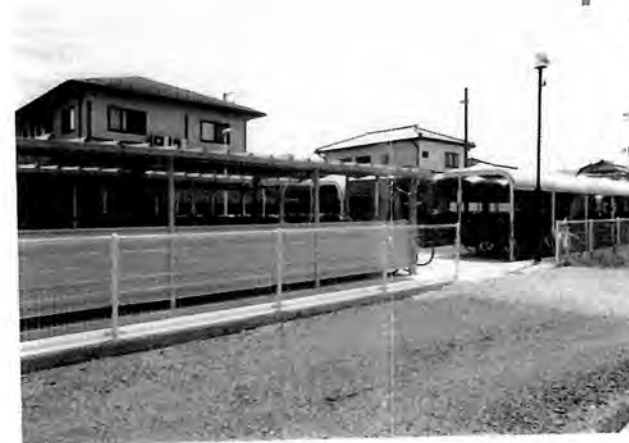
安積永盛駅東口駐輪場
