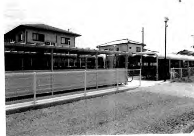
安積永盛駅東口駐輪場
