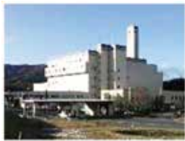
河内クリーンセンター
