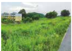
緑ヶ丘地区の道路法面
