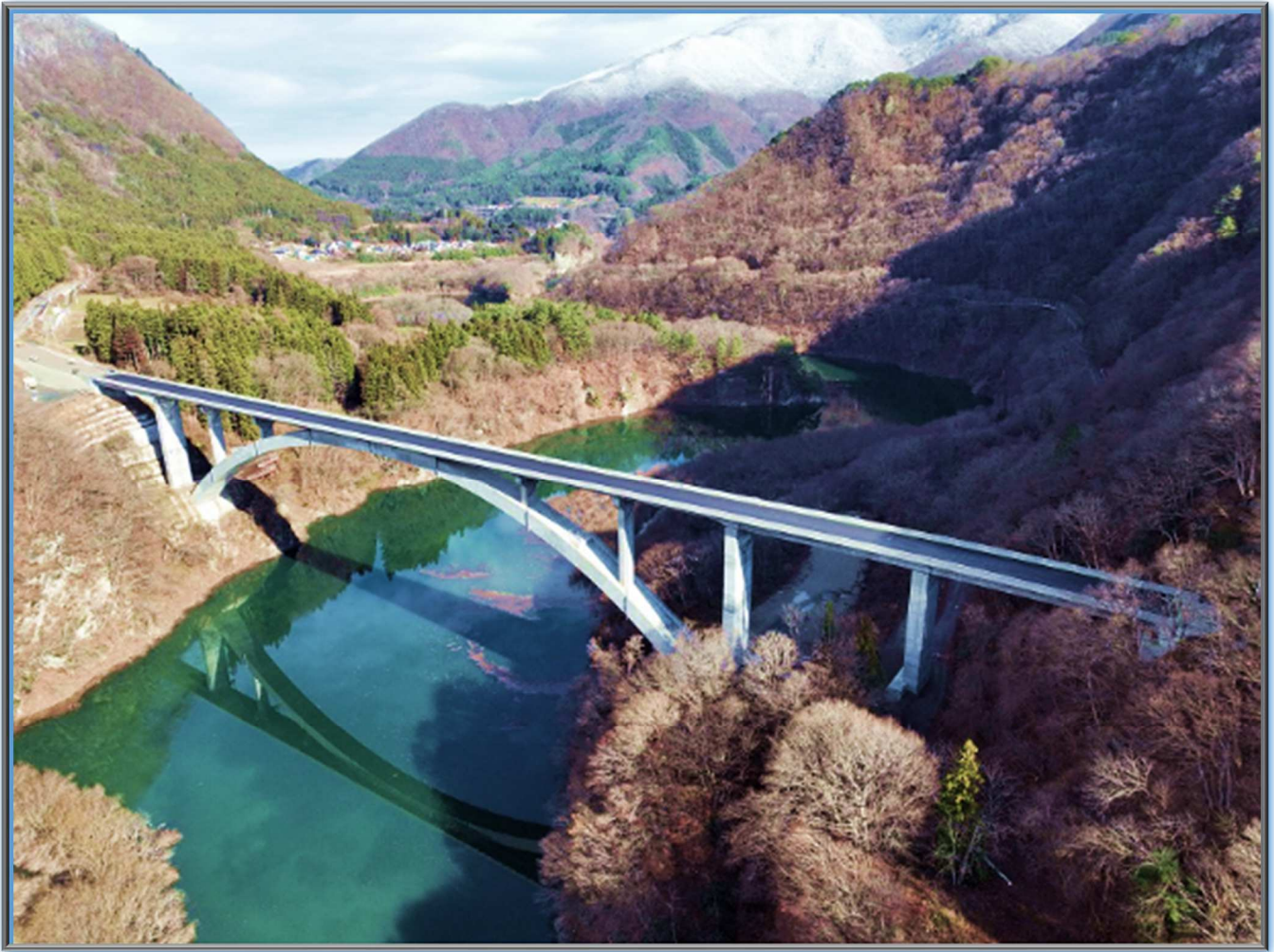
下郷大橋（国道118号小沼崎バイパス）
