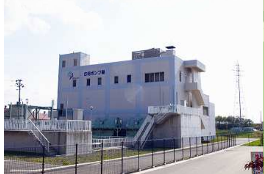
古坦ポンプ場（富久山町久保田字古坦 地内）
