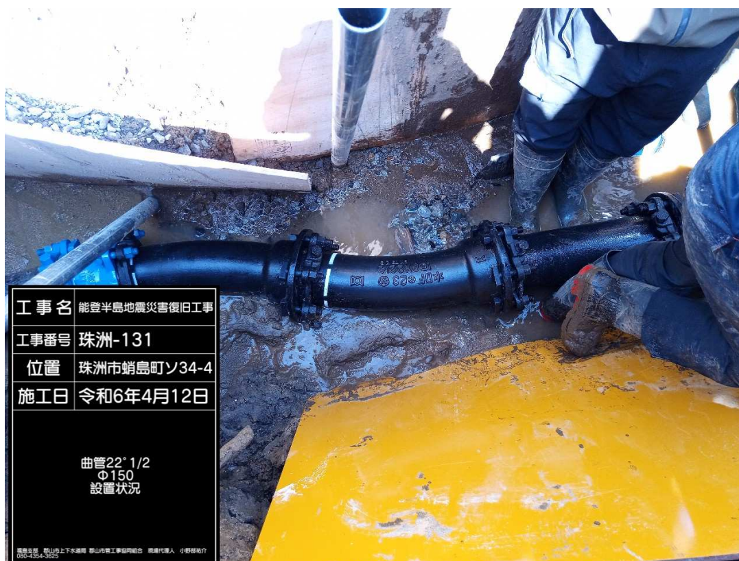
応急復旧現場
