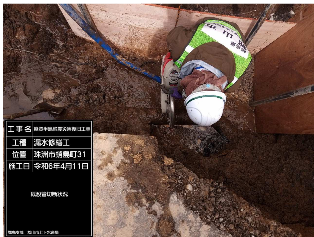
応急復旧現場
