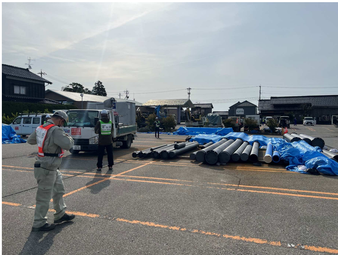
応急復旧現場
