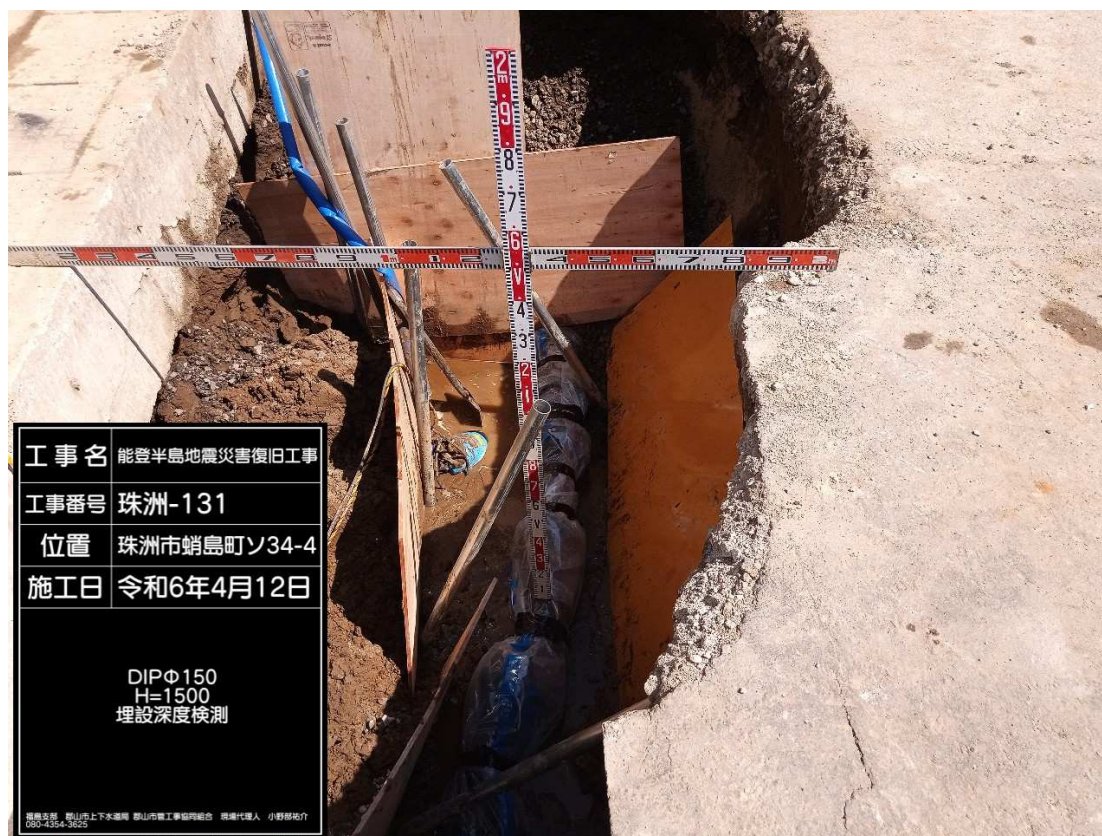
応急復旧現場
