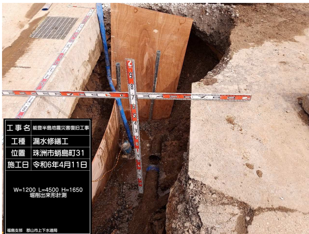
応急復旧現場
