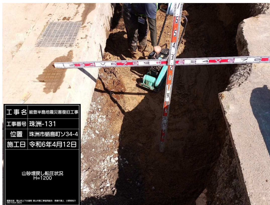
応急復旧現場
