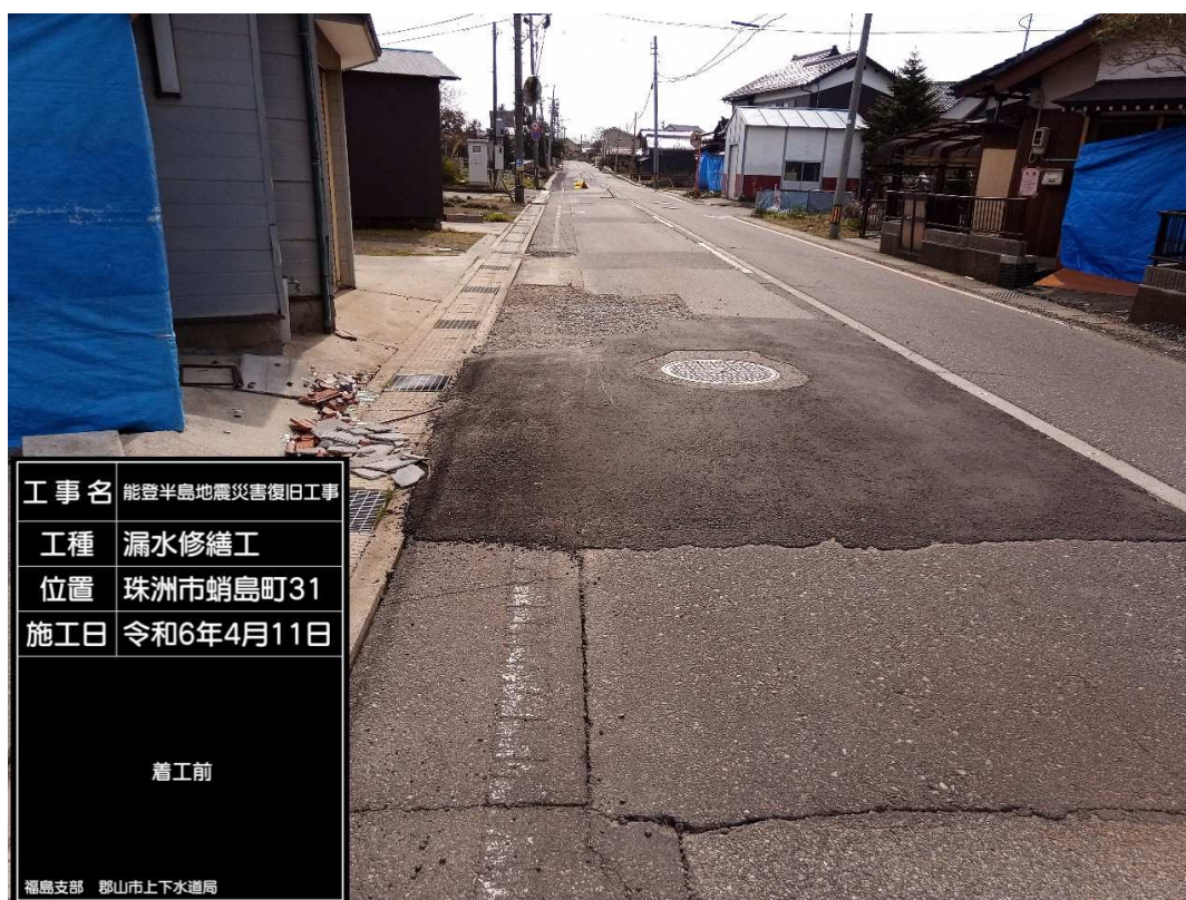
応急復旧現場(珠洲市内・着工前)
