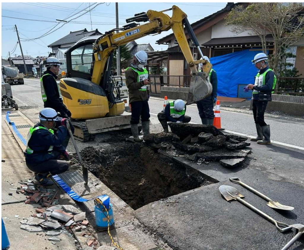
応急復旧現場(珠洲市内・作業中)
