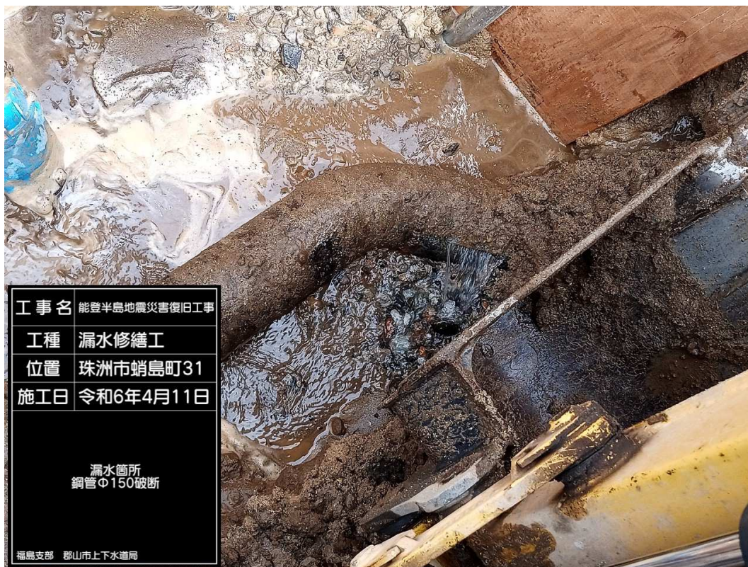
応急復旧現場
