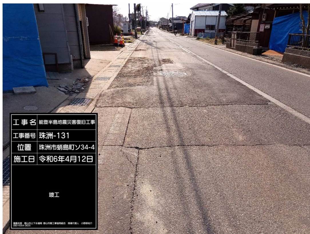
応急復旧完了
