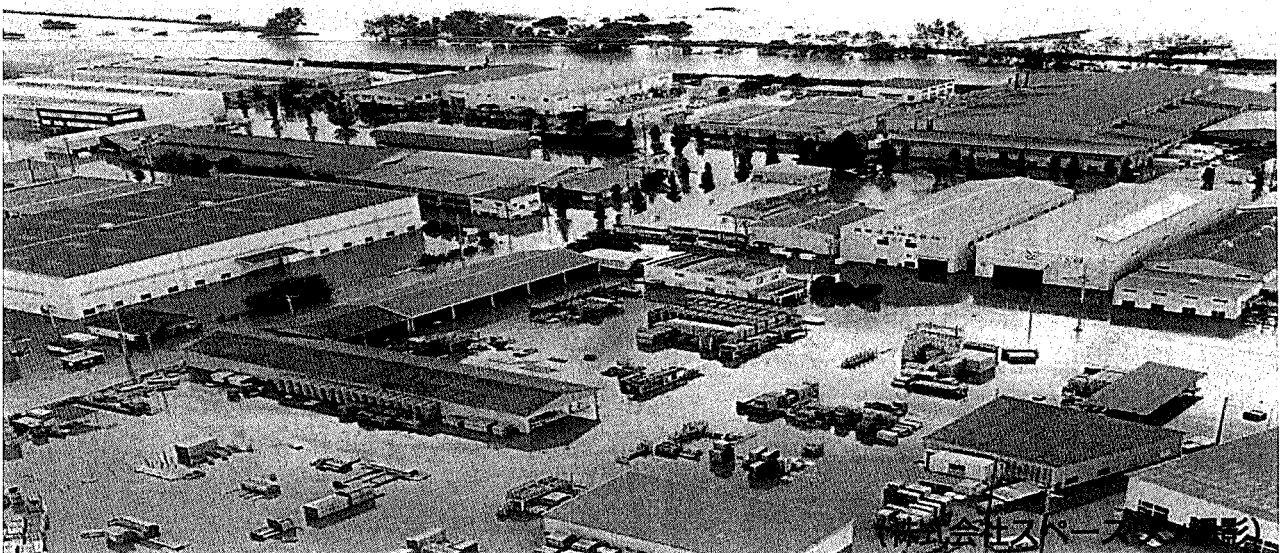
▲ 郡山中央工業団地の浸水状況 2019年10月13日 10時頃
