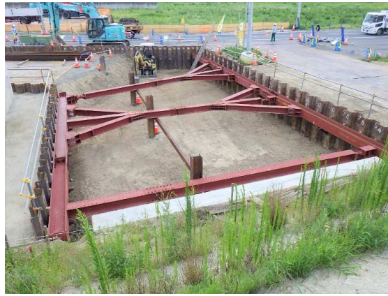
ポンプ施設部支保工設置状況
