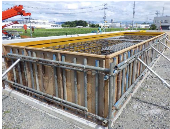
発電機置場基礎の型枠完了
