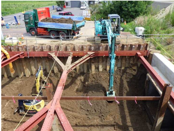
ポンプ施設部掘削状況
