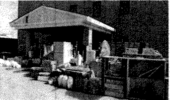
今回の台風で富久山クリーンセンターも甚大な被害にあいました。写真は被災5日後の17日に共産党市議団が調査に入った時のものです。施設内の各種設備も水浸しになりましたが、粗大ごみ処理施設及びリサイクルプラザは11月下旬に焼却施設は12月下旬までに仮復旧できる見通しです。
