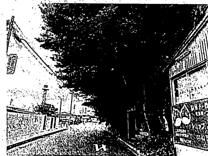
通行の妨げとなっている道路脇の樹木
